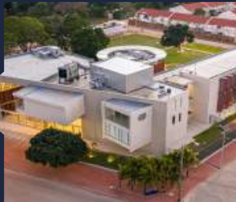
Campus Santa Cruz Prolongación Piraí Av. Ivo Kuljis entre 6to. y 7mo. anillo
