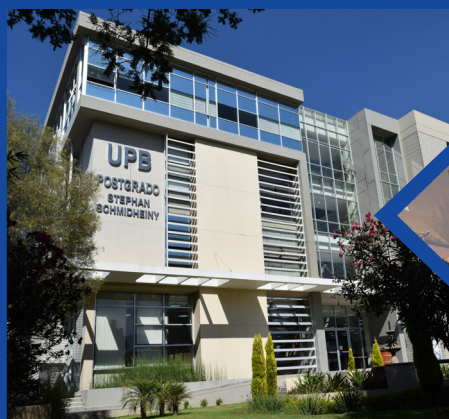
Edificio de Postgrado "Stephan Schmidheiny" Campus Julio León Prado - Cochabamba
